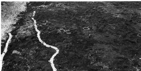
5-Fブロック全景(北から)
