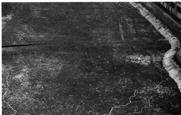
4-Gブロック全景（北から）
