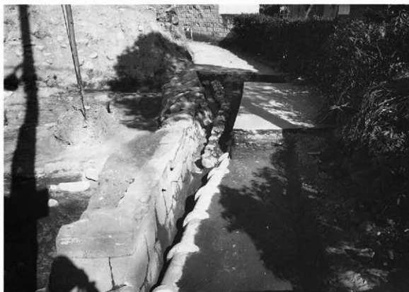
上段石垣（南東から）
