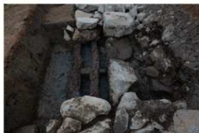
20. D②区トレンチ石積2下胴木検出(東から)
