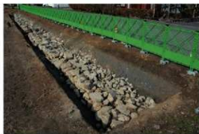
14. D②区完掘 (南東から)
