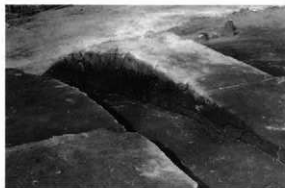
E区中世盛土(A・Bセクション)
