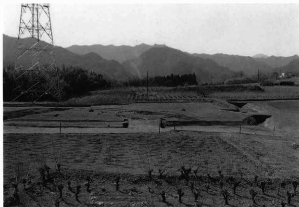
1 A郭全景（北から）
