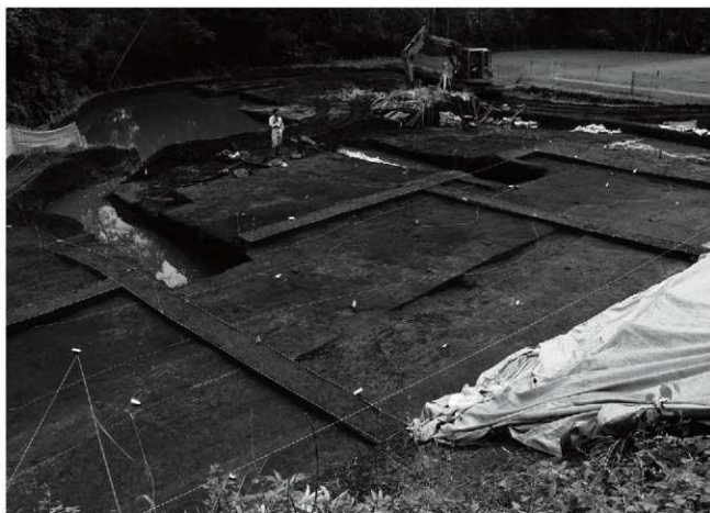
C区調査風景（北東から）
