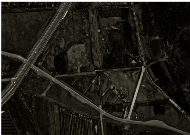
(1) 10~13区全景 (南方より)
