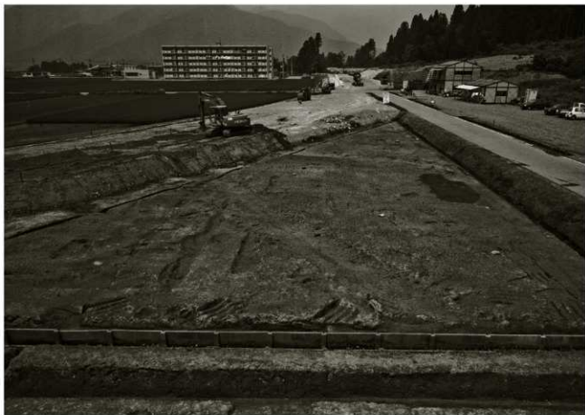
(2) 5区全景 (南方より)
