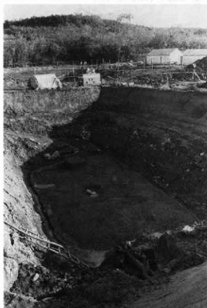
F区 掘り上がり(東から)
