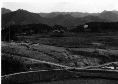
西斜面下位 掘り上がり(北西から)
