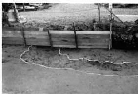
1号古墳(東区)近景 南西→
