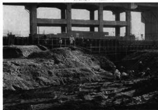
シートパイル打設後の調査状況
