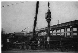
シートパイル打設状況
