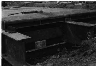
土砂搬出路橋の構造
