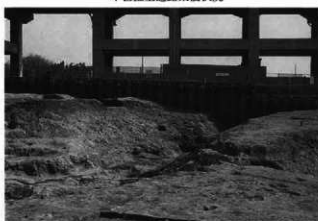
シートパイル施工状況 (完掘後)
