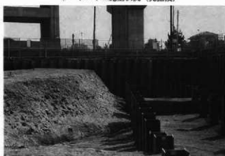
シートパイル施工状況 (完掘後)
