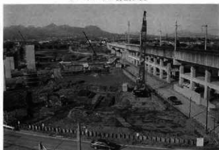
シートパイル打設状況
