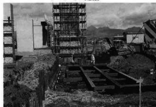
土砂搬出路架橋状況
