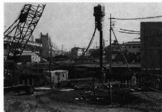
シートパイル引き抜き状況
