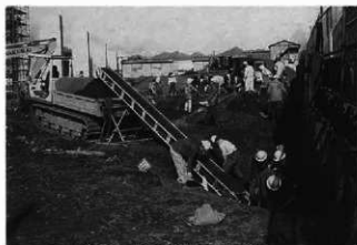
シートパイル打設後の調査状況
