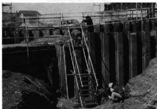
階段設置状況
