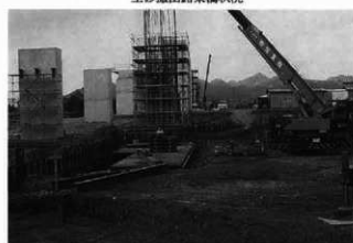
土砂搬出路橋鋼板設置状況
