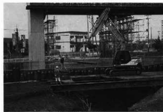
搬出路橋下の掘削状況
