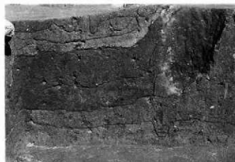
26号住居跡 竈2 土層断面
