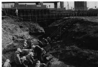
シートパイル打設後の調査状況
