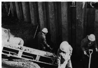
シートパイル打設後の調査状況
