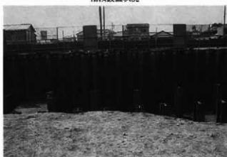
シートパイル施工状況 (完掘後)
