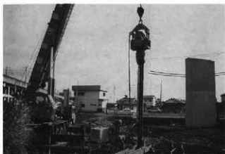
シートパイル打設状況
