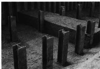
タイロッド施工状況 (完掘後)
