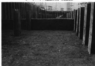
シートパイル施工状況 (完掘後)
