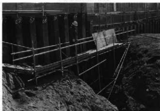
中世掘上通路架橋状況
