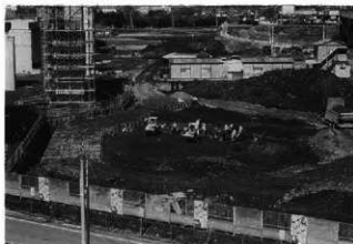
打設完了後調査着手状況
