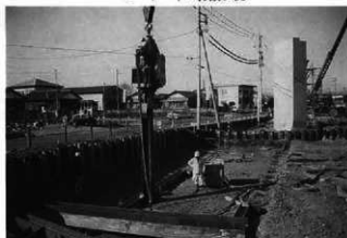
タイロッド打設状況
