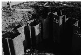
シートパイル屈曲部
