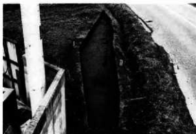
3区西トレンチ調査区全景 南西→
