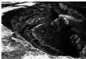
2号溝部分 (南から)
