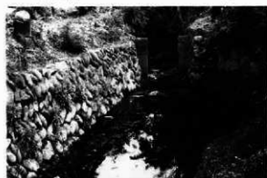
同左くるま川堰門
