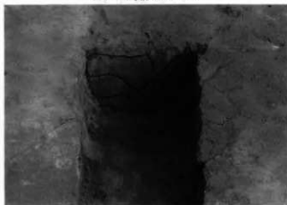
AY-28号溝セクション
