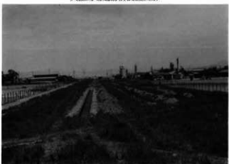
武蔵島地区トレンチ配置状況
