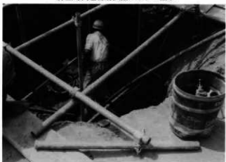
AY-5号井戸調査風景
