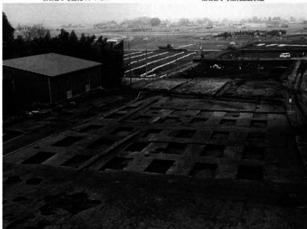
旧石器試掘トレンチ設定状況透景
