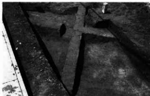
2. 34号溝と1号道路 (手前)の断ち割り (北東から)
