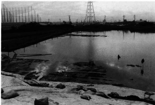
1. 冠水した調査区（調査中、台風により3回調査区が冠水した。本線部分、東から）
