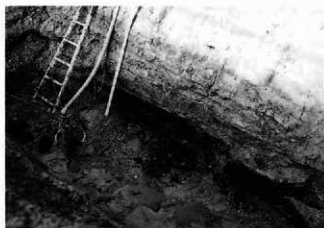
3 東区中央No.1 調査風景 (南から)
