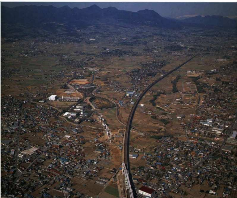
開通から13年目を迎えた上越新幹線(右)と 現在建設中の北陸新幹線(左)
