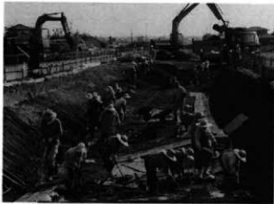
IV面調査風景 (東区西：北西から)
