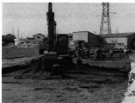
バックホーによる表土掘削（西区：東から）
