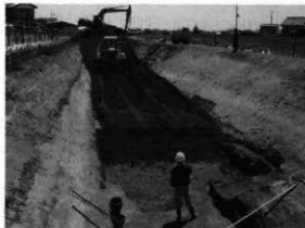
調査区埋め戻し風景（西区：北西から）
