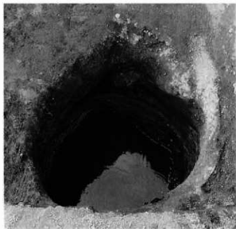
2. 37号井戸完掘状況
