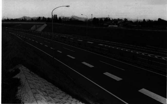
1 白倉下原遺跡 (南東から)
