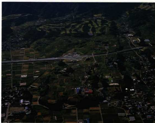
遺跡地の現況と周辺の地形（北から）
