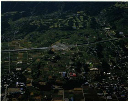
遺跡地の現況と周辺の地形（北から）
