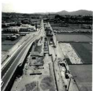
51次調査区全景（北斜上空から）
