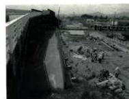
52次調査風景（北から）
