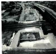
51・52次調査区全景（南斜上空から）
