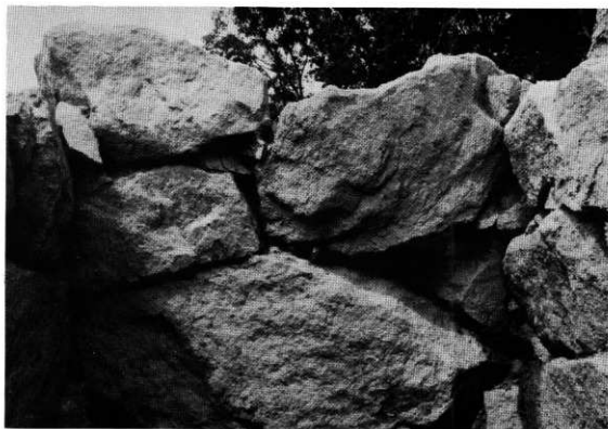
3号墳奥壁（南西から）
