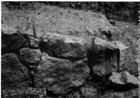
3号墳側壁 奥壁→横道部（北西から）
