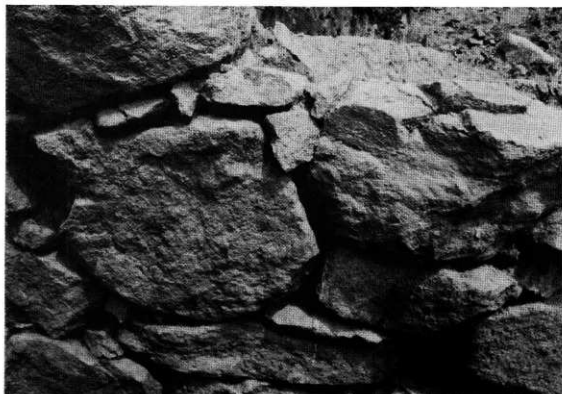
3号墳側壁 奥壁→横道部(北西から)
