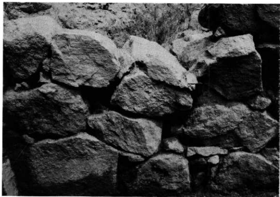
3号墳側壁 奥壁→横道部（北西から）
