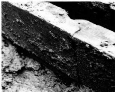
第60図 樋管の継ぎ目
