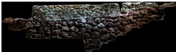
SW1 沈殿池石積立面 (東から)
