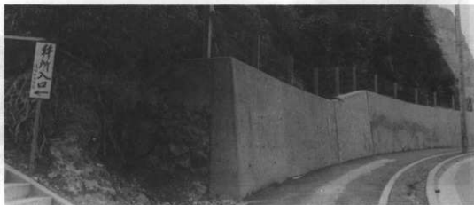
首里西森遺物散布地 近景(南側より)
