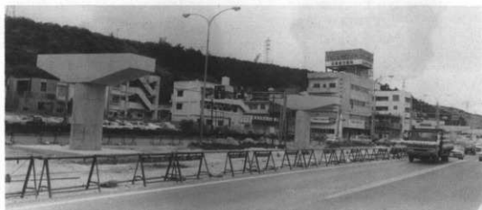
住吉遺物散布地 遠景（北側より）
