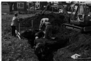
A 工事立会状況(南東から)
