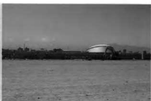
D 調査状況(北東から)
