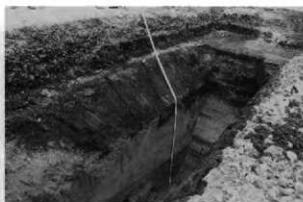
G 工事立会状況
