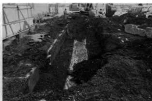
E 工事立会状況
