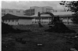
B 事業地近景(北東から)
