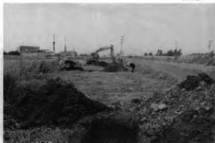
A 事業地近景(北東から)
