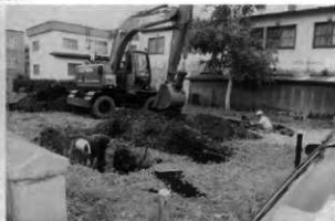
B 事業地近景(南西から)
