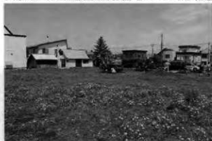
A 事業地近景(北東から)
