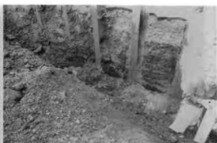
F 工事立会状況
