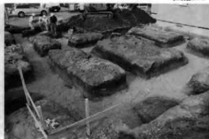
A 工事立会状況
