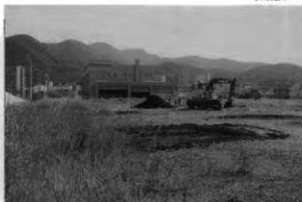
A 事業地近景(北東から)
