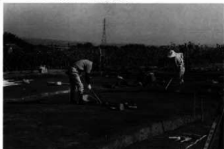
4. III区作業風景
