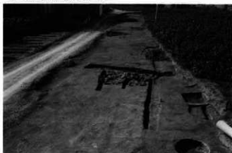
8. II区取り付け道路部 (東から)
