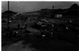
5. III区作業風景
