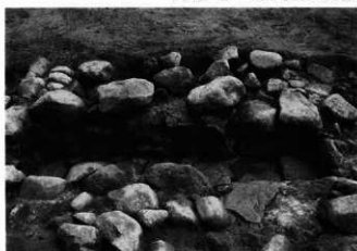
2. 南壁構築状態
