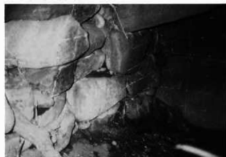
5. D号墳石室左壁構築状態
