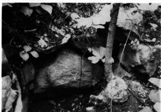
4. E号墳玄室右壁構築状態
