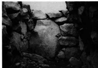
6. 奥壁構築状態
