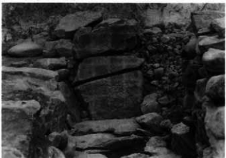
7. 奥壁構築状態
