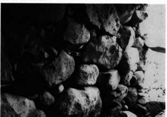
8. 石室右壁構築状態
