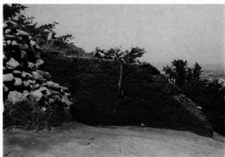
3. 奥壁の裏込め被覆と墳丘封土
