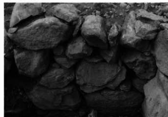
7. 左壁構築状態
