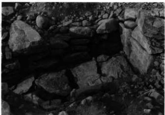
5. 玄室左壁構築状態
