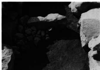
4. 榑石設置状態
