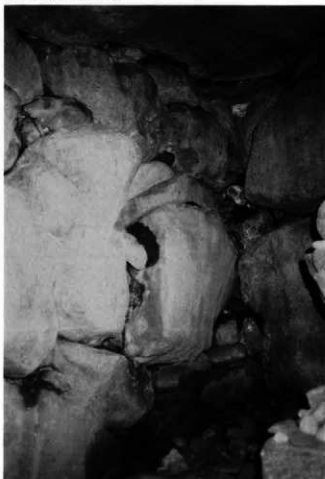
3. 石室左隅構築状態
