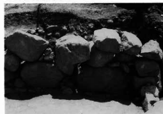
8. 玄室右壁構築状態 (北西より)
