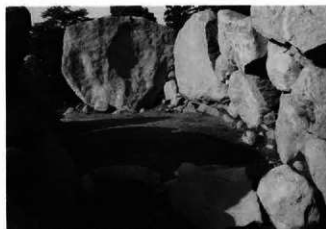
3. 玄室右壁・奥壁構築状態 (南西より)
