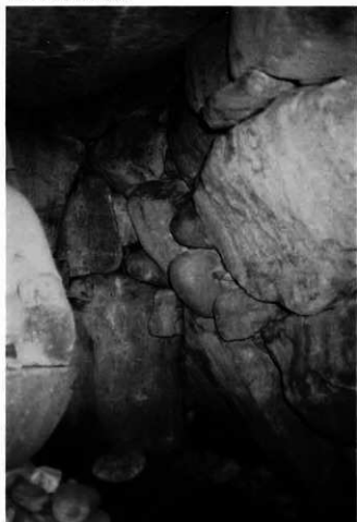
4. 石室右隅構築状態
