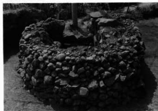
6. 石室裏込め被覆全景 (東より)
