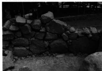
3. 玄室左壁構築状態
