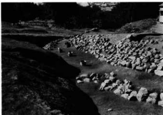
2. 張り出し部全景 (東より)
