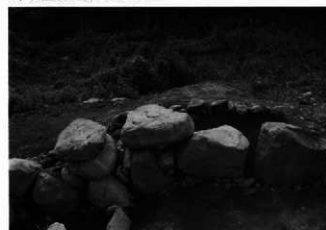
7. 玄室左壁構築状態 (南東より)
