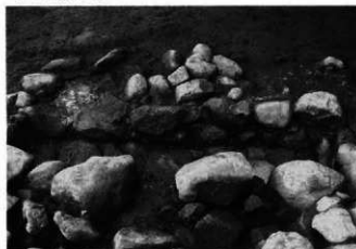
3. 北壁構築状態
