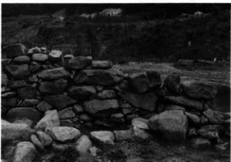
6. 玄室右壁構築状態
