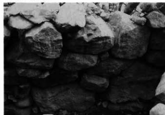
8. 右壁構築状態
