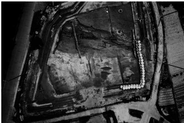
(2) B地区全景(上が南)
