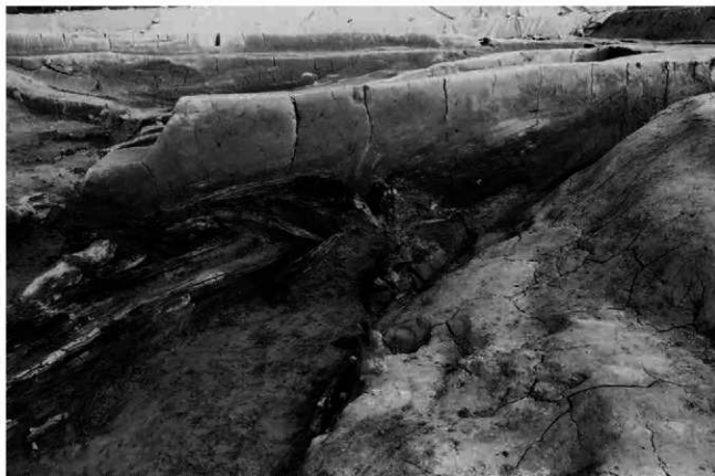
(1) B地区S D22土層断面<断面1 南部護岸材D検出状況> (西から)
