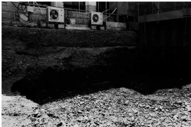
(1)北地区南部(8トレンチ)断ち割り状況(北西から)
