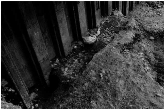
(1)北地区溝 S D 100(東から)
