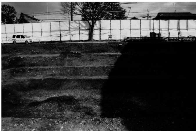
(2)北地区北東部(3トレンチ)断ち割り状況(西から)
