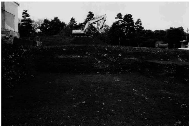
(1)北地区中央部(3トレンチ)断面(東から)
