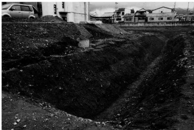
(2)南地区(4・7トレンチ)断ち割り状況(南西から)
