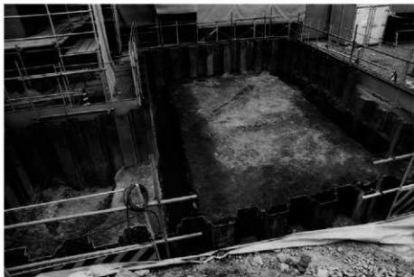
(1) 南地区北部(9トレンチ)全景 (北西から)
