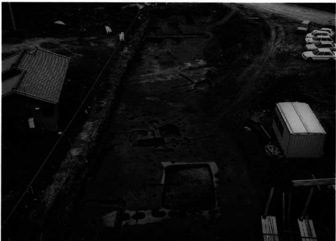
2・6区側道部分全景 東から
