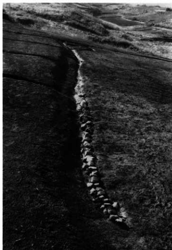
日A1号溝(暗渠)全景(東から)
