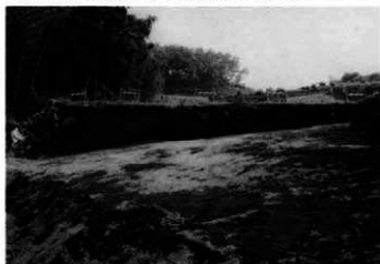
1号屋敷東側盛土セクション（北から）
