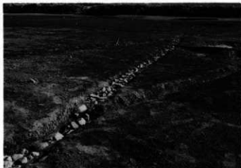
日A11号溝(暗渠)全景(北から)
