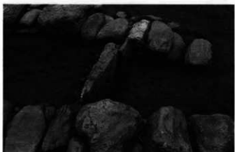
3 櫛石の設置状況（西から）
