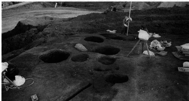
1号特殊遺構調査風景
