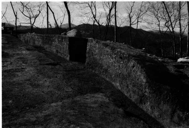
3 礎基増断ち割り状況
