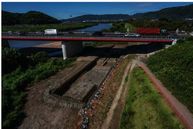
(2) 遺構面掘削状況(東から)
