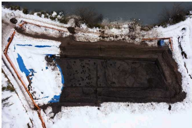
(1) 遺構面掘削状況(右が北)
