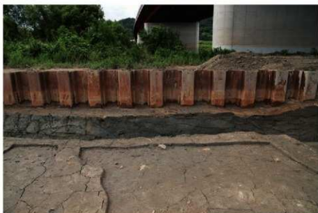
(2)南壁断面②(西から)
