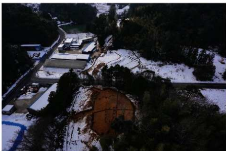
(2)Ⅰ区調査状況(北から)
