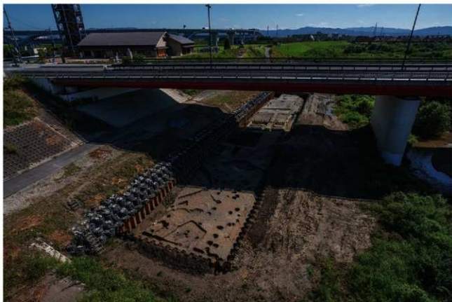
(1) 遺構面掘削状況(西から)
