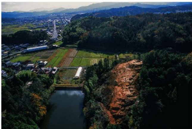
(2)調査地遠景(北から)
