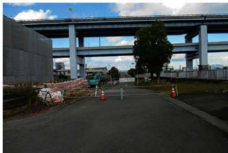
(1) 第39次調査前状況(南から)
