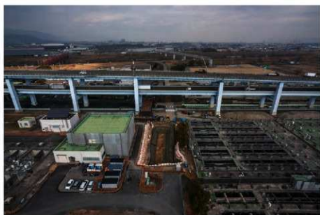
(3) C 1 地区第 2 面遠景(南から)
