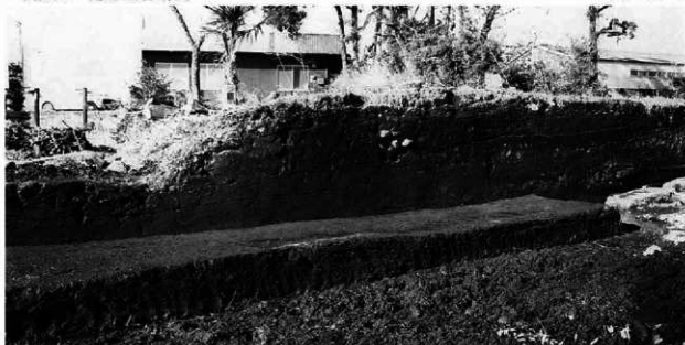
西壁断面の状況 (a-a')
