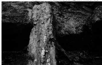
木道の自然木を杭で固定した状況
