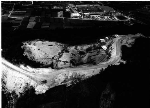
野上塩之入遺跡 A区全景(南から)
