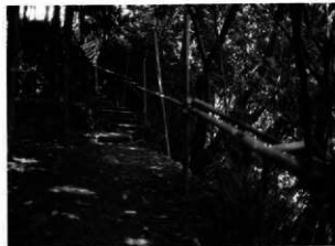
安全柵 施工状況
