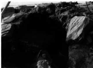
1号墳 天井石崩落状況(南から)
