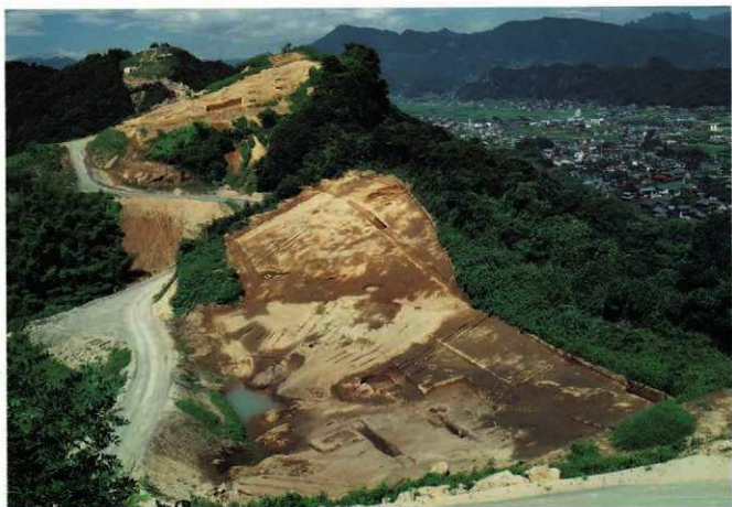
野上塩之入道跡 塩之入城道跡全景（手前 野上塩之入道跡A区、中 B区、奥 塩之入城道跡）
