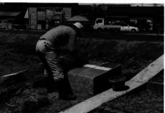
5. 成塚石橋遺跡説明板設置状況
