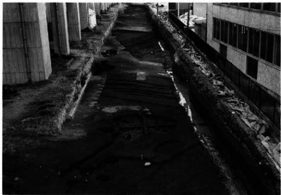
2区西側道全景（北より）
