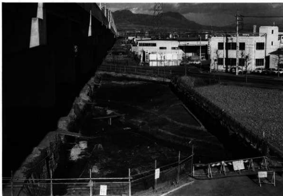
1区東側道全景 (南より・背景の山は標名山)
