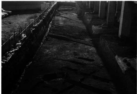
2区東側道全景（北より）
