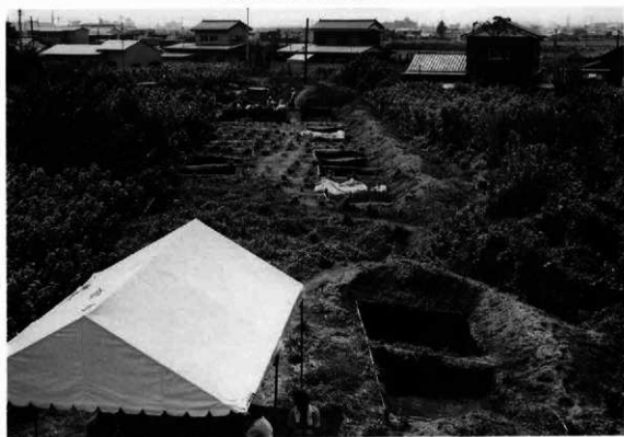
1・2区本線グリッド全景（北より）
