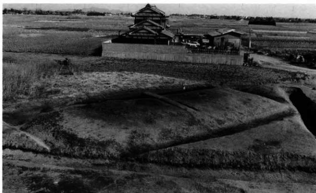
12号古墳全景（手前と右方の溝は館跡の周堀） W→
