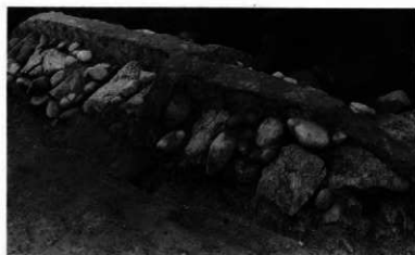
8号古墳石柩被覆状況
