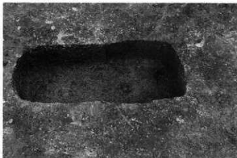
2 坑底部確認状態
