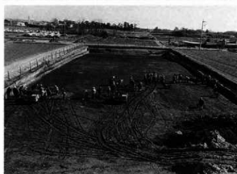
2 C区 砂壤土下の調査
