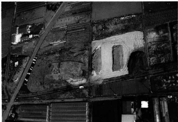
1 橋脚部埋め戻し状況
