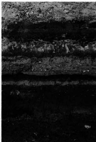
北カルバート部北壁 50-H09
