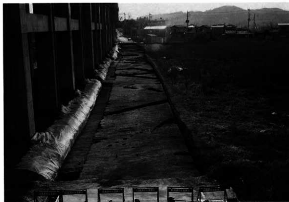
5区～10区西側道全景（北より）
