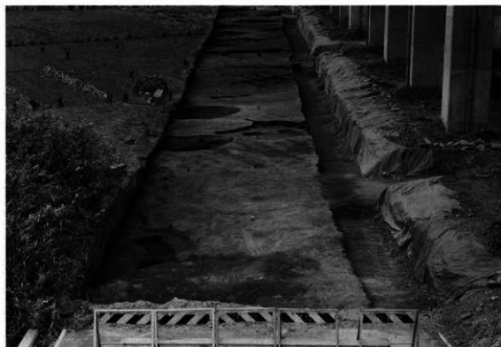
7区～10区東側道全景（北より）
