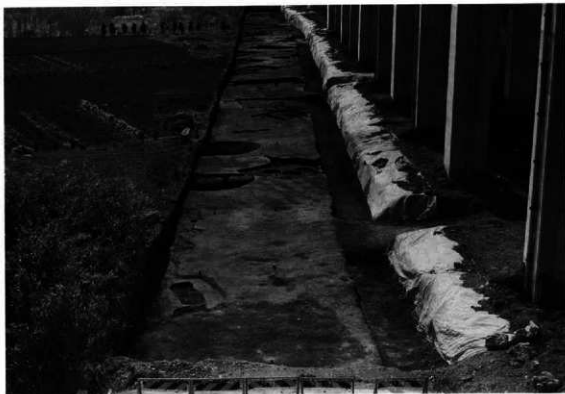
5区～10区東側道全景（北より）
