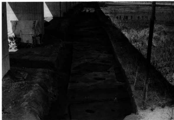
5区・6区東側道全景（南より）
