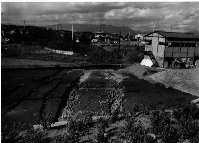
道路遺構全景
