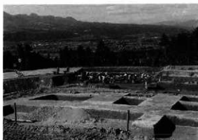
2 A区第3区の調査
