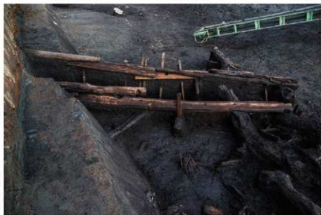
(3) 井環 S W7131 上部除去状況 (西から)
