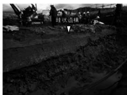
8 M地区の南断ち割りトレンチの畦状遺構の検出状況
