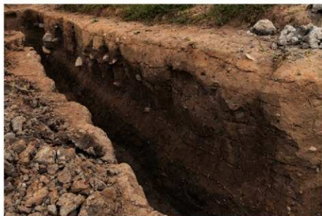
(2) A1地区東壁北側断面 (南西から)
