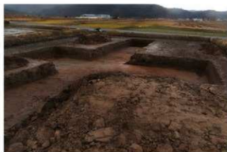
(3) B3トレンチ全景(南東から)
