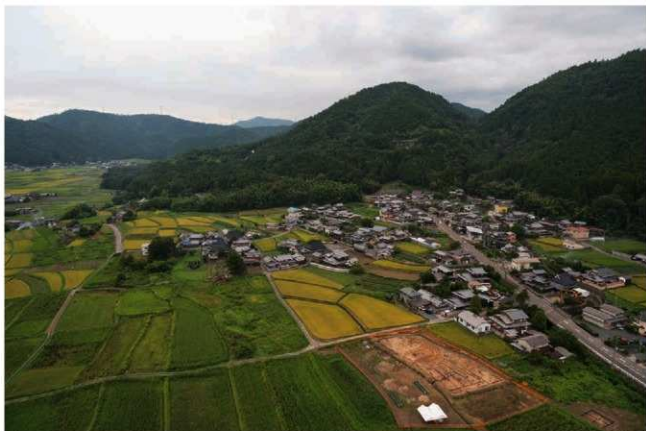
(1) A1地区全景(北から)
