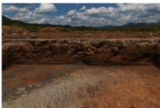
(8) F9トレンチ北壁断面(南から)
