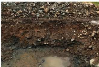
(2)D1トレンチ南壁断面(北から)
