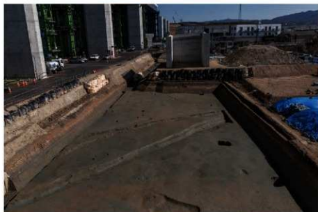
(2) 調査トレンチ東半全景 (西から)
