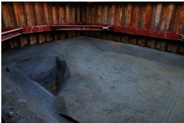
(2) F18区基盤層面完掘状況(南東から)
