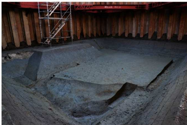
(2) F22区完掘状況(北東から)
