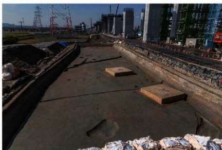
(3)調査トレンチ西半全景 (東から)
