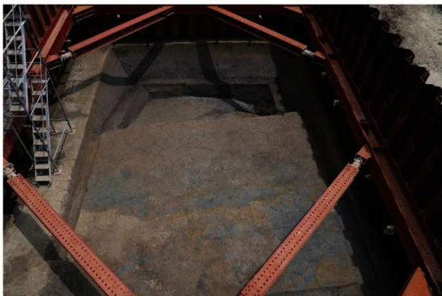
(2) F13区基盤層面完掘状況(西から)
