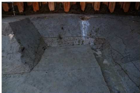
(2) F22区高塚115断削状況 (北から)
