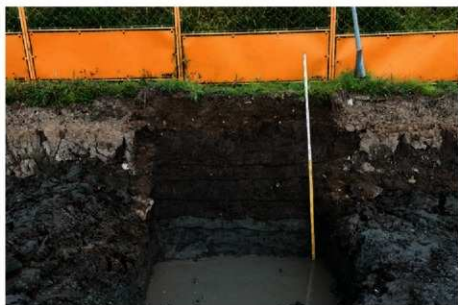
(2) NX20第3区北壁断削2土層 (南から)
