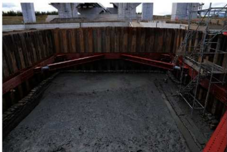
(1) F13区 S D1302検出状況 (東から)
