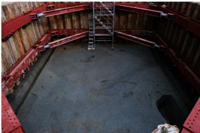
(1) F17区中世面完掘状況(西から)
