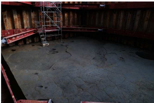
(2) F17区中世面完掘状況(北西から)
