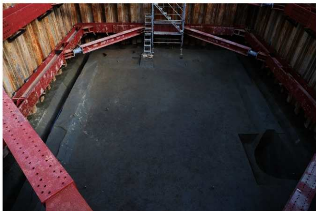
(1) F17区基盤層面完掘状況(西から)
