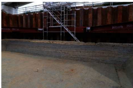
(2) F16区北壁土層断面 (北西から)
