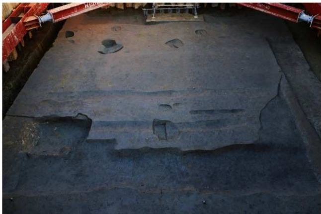
(1) F18区中世面完掘状況(西から)
