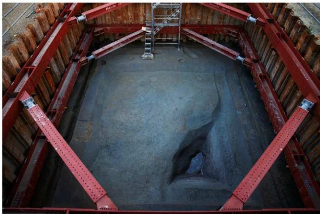
(1) F18区基盤層面完掘状況(西から)
